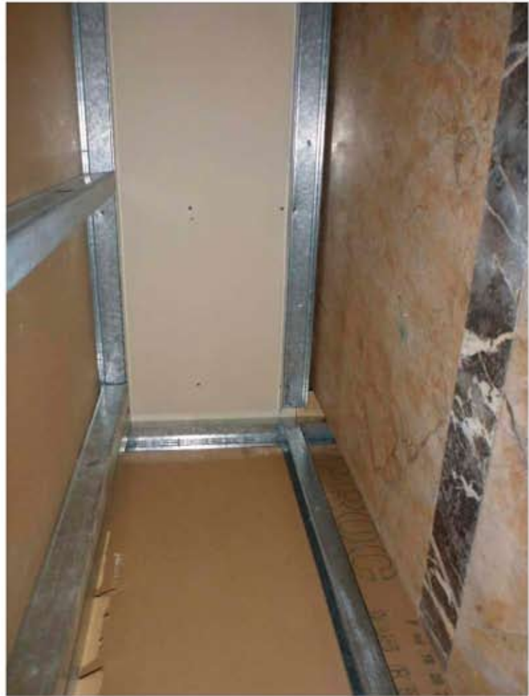
Afb. 23. Beeld van de plaatsing van de metalstudwanden ten opzichte van de marmeren kolommen in de centrale hal op de begane grond
